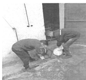
用消防沙袋围堵水沟
