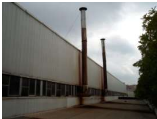
ST3 定型机排气筒
