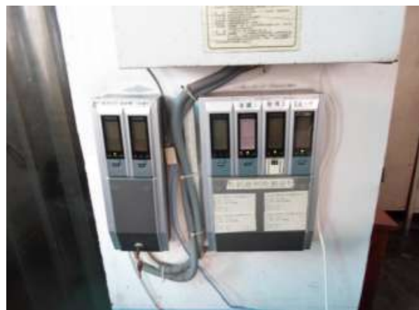
甲苯、丁酮储罐区有机溶剂实时探测报警器
