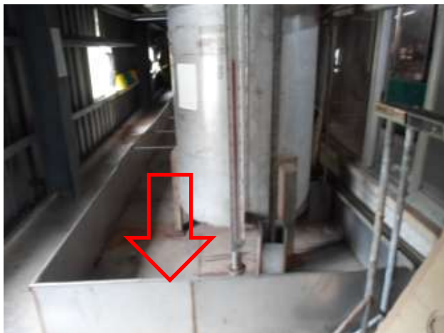
乙酸储罐围堰
