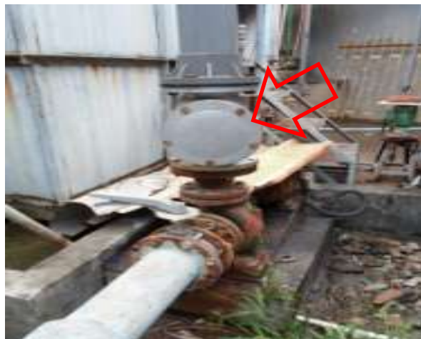
污水排放口应急泵
