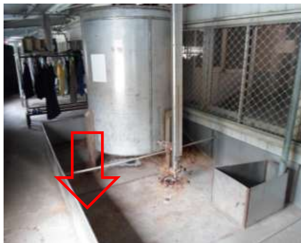
甲酸储罐围堰
