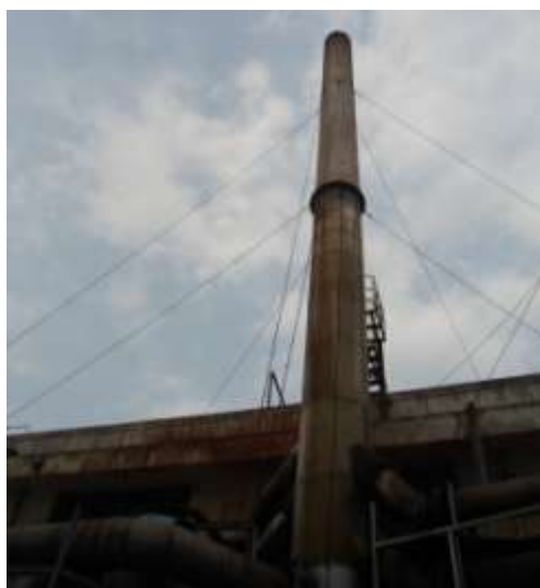
图 10.1-5 锅炉排气筒照片
