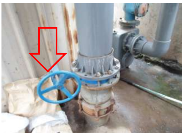
污水排放口应急阀门
