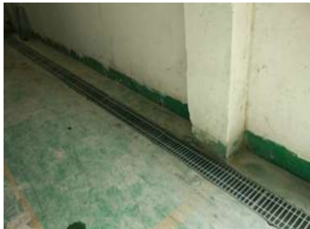
化学品贮存区导流沟
