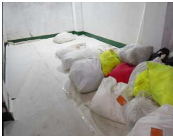
危险废物仓库地面防渗漏措
