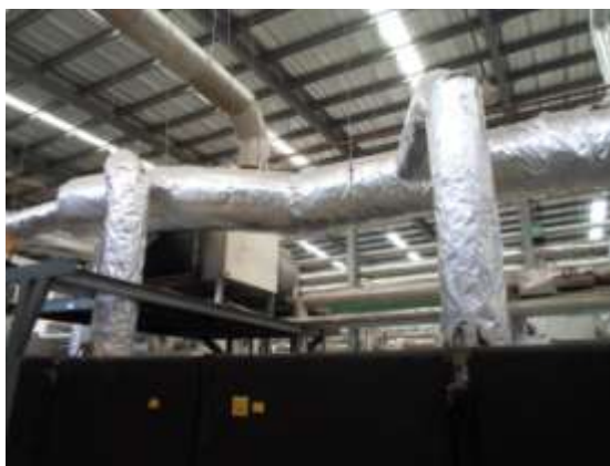
余热回收管道
