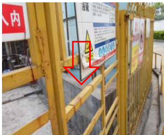
液碱储罐围堰
