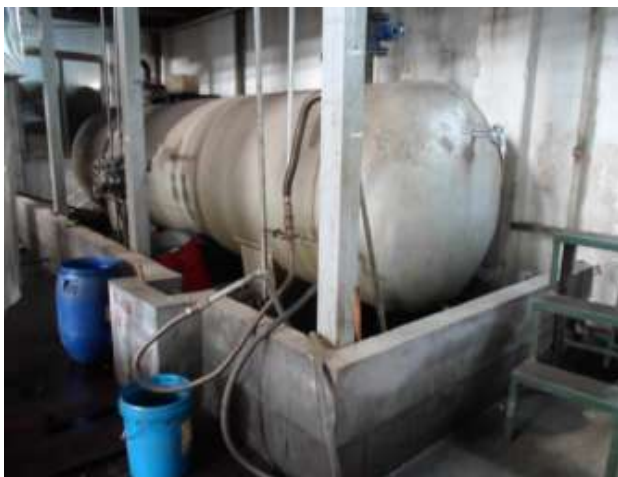
导热油贮存区防泄漏措施
