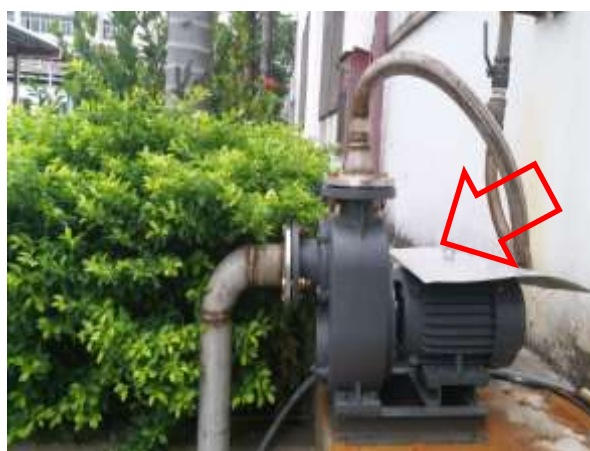
雨水排放口应急泵
