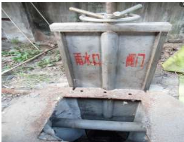
雨水排放口应急阀门
